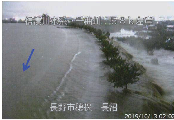
越水状況 (10 月 13 日 2 時頃)
